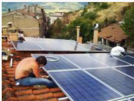
Umberto, Daniele e Giuseppe durante la costruzione di un impianto fotovoltaico nel 2009.
